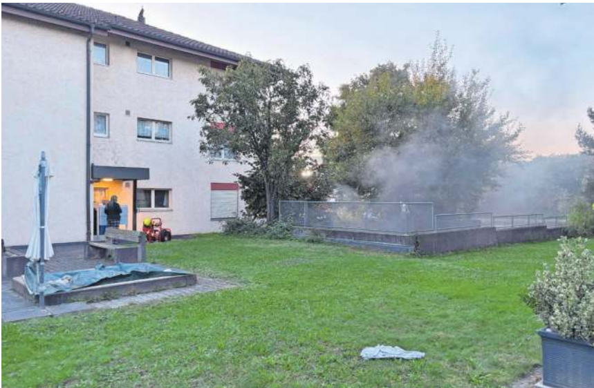
Mehrere Mehrfamilienhäuser teilen sich die Tiefgarage.
