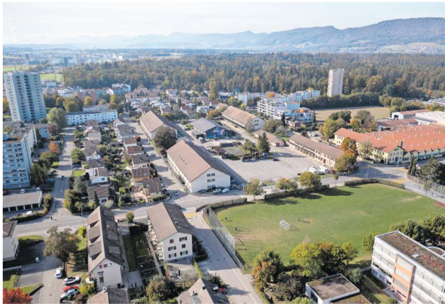
Das Areal Zeughaus (Bildmitte) sowie das Areal Artoz (angrenzend rechts) werden aus der Gesamtrevision ausgeklammert. Bild: Michael Küng
